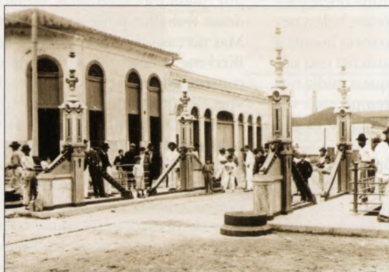
1907: a inauguração do Canal 1, em Santos ( no alto ), e uma das pontes de concreto
