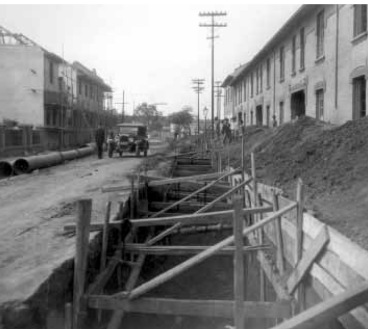
Obra de assentamento da adutora no bairro Tatuapé para abastecer o reservatório de Belenzinho, em São Paulo (s/d)
