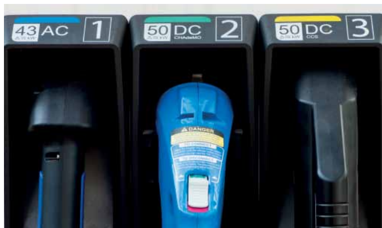
Diferentes padrões de plugs e conectores em eletroposto de recarga rápida de veículos elétricos
