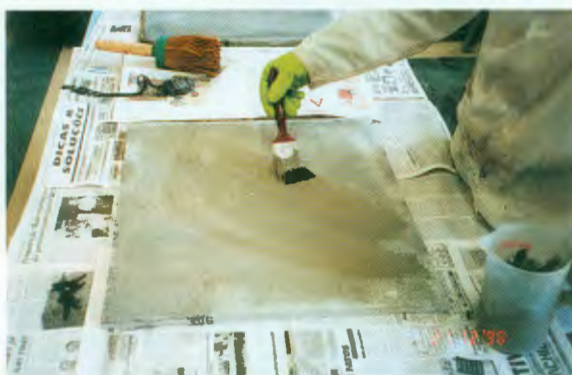
A pesquisa desenvolveu também a maneira correta de fazer a preparação e o assentamento do contrapiso
