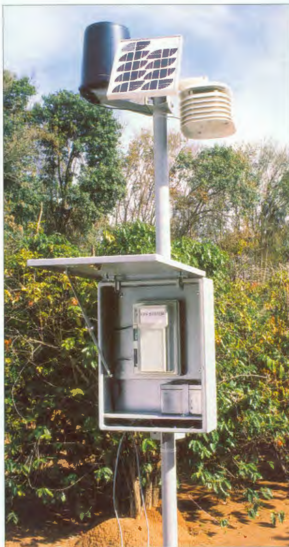
Painel solar mantém bateria e sensores do equipamento
