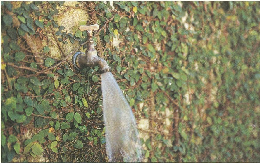
Do poço artesiano à torneira, agora sem cheiro ruim
