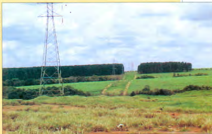
Área onde serão montadas as futuras instalações
