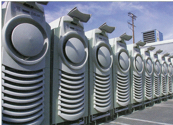
Microturbinas a biogás: 30 quilowatts de energia elétrica
