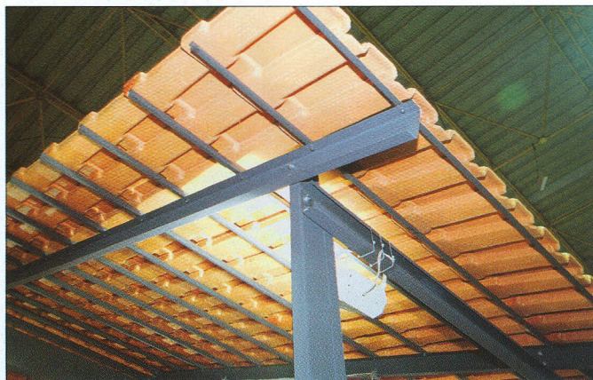
Engradamento metálico substitui cobertura tradicional
