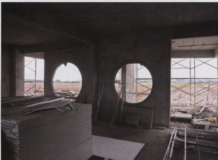
No canteiro de obras, operários concluem as instalações que, em março de 2005, receberão a primeira turma de 1.020 alunos
