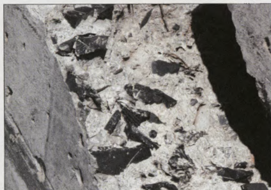
Barreira de concreto com borracha na marginal do Tietê, em São Paulo. Ao lado, pedaços de pneu incorporados ao cimento
