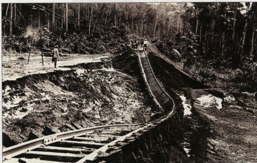
Foto de Dana Merrill, de 1910, mostra deslizamento durante a construção da chamada Ferrovia da Morte
