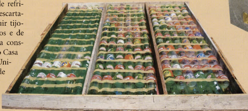
Casa é montada com painéis compostos de colunas verticais de garrafas e argamassa
