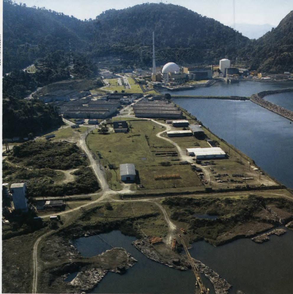
Canteiro de obras de Angra 3: US$ 750 milhões já investidos
