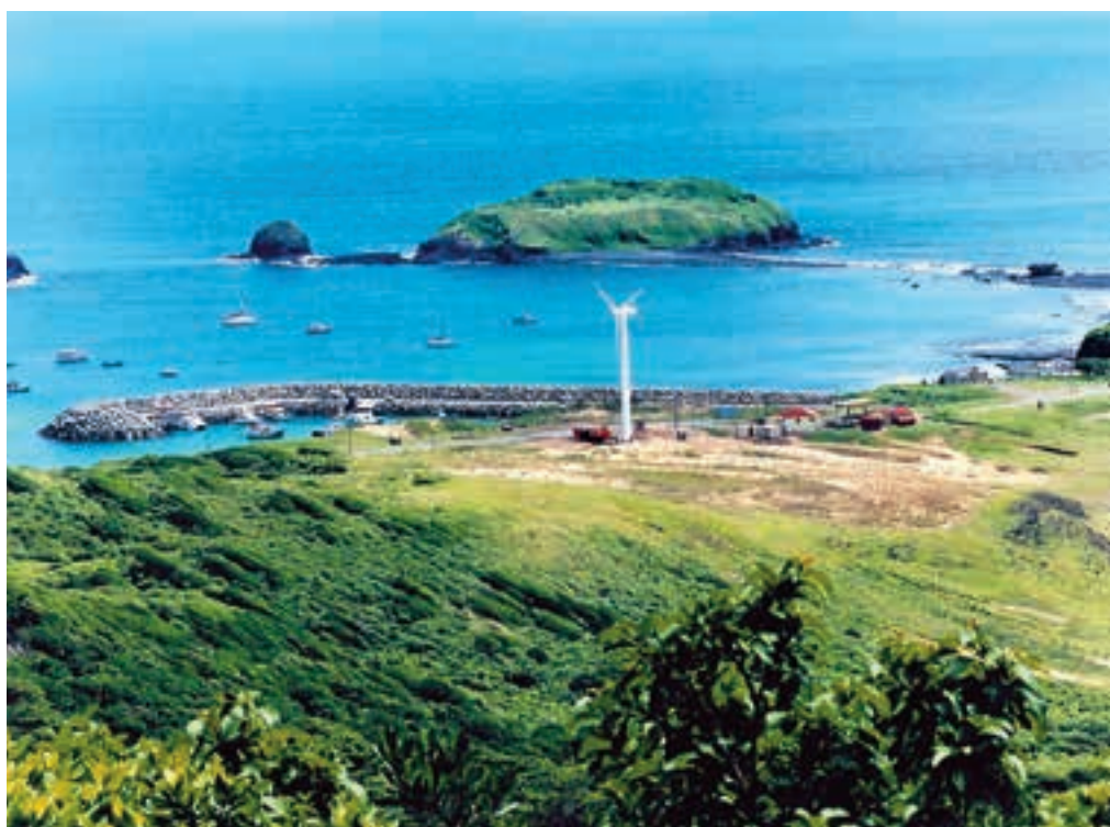
Usina em Fernando de Noronha, instalada em 1992, supre 10% da energia da ilha
