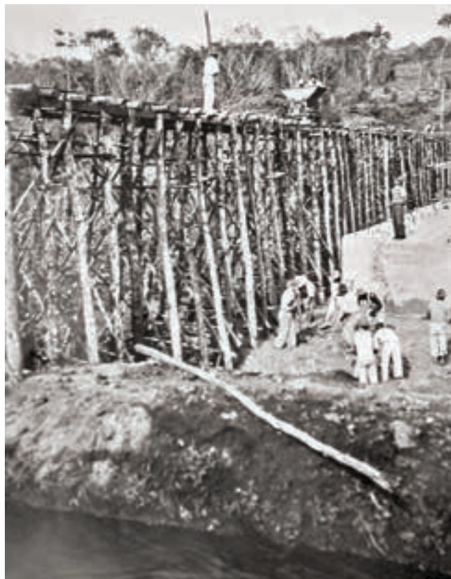
Construção da barragem da Usina de Jacaré, na década de 1940
