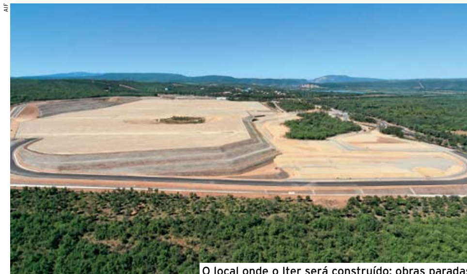
O local onde o Iter será construído: obras paradas
