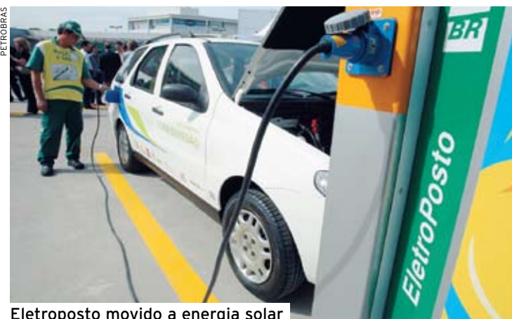
Eletroposto movido a energia solar
