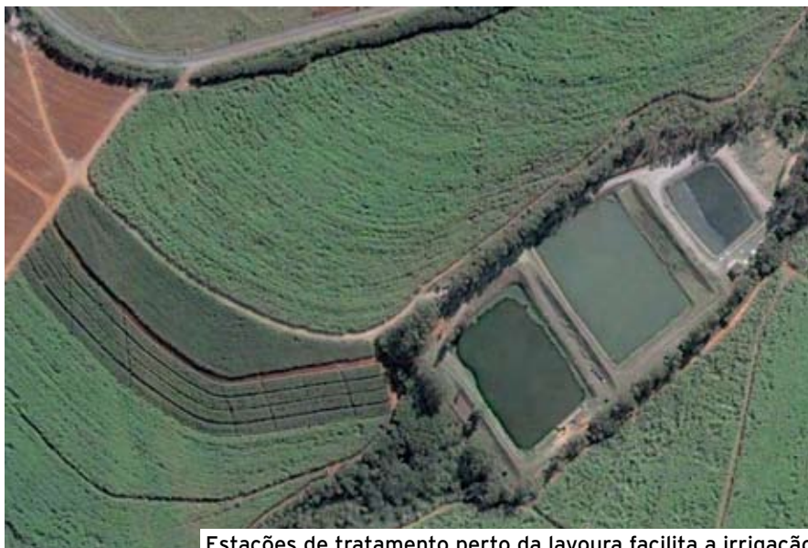
Estações de tratamento perto da lavoura facilita a irrigação
