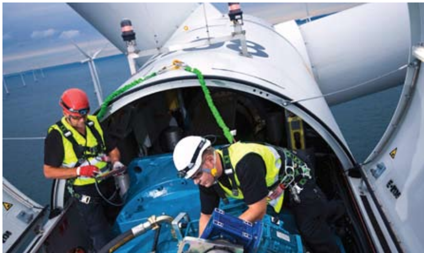
Turbinas instaladas em alto-mar na Dinamarca
