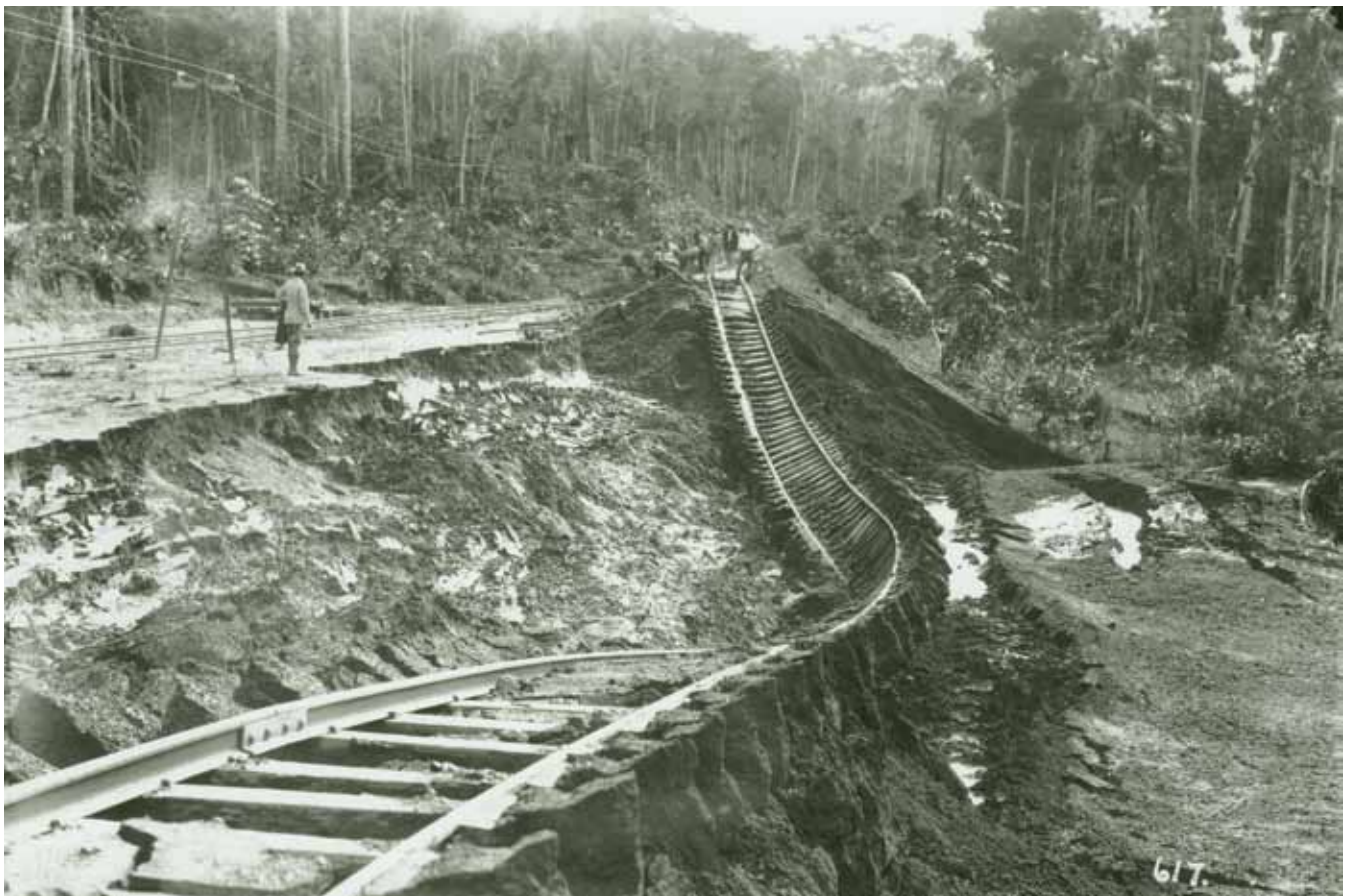
Deslizamento de trilhos na estrada de Ferro Madeira-Mamoré. Foto de Dana Merrill (1910)
