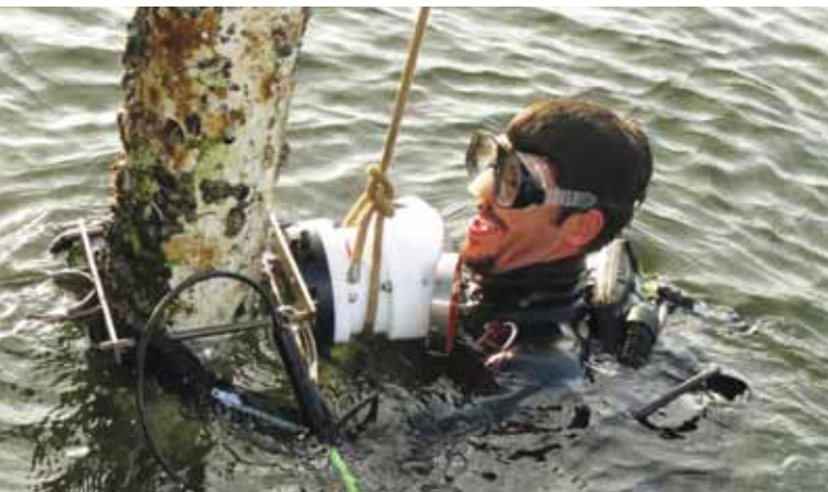
Jasão: em Cananeia, instalando um medidor de correntes marinhas
