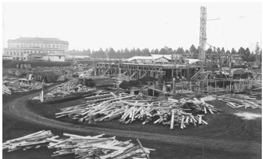
Construção do prédio central da Faculdade de Medicina da USP, em 1920
