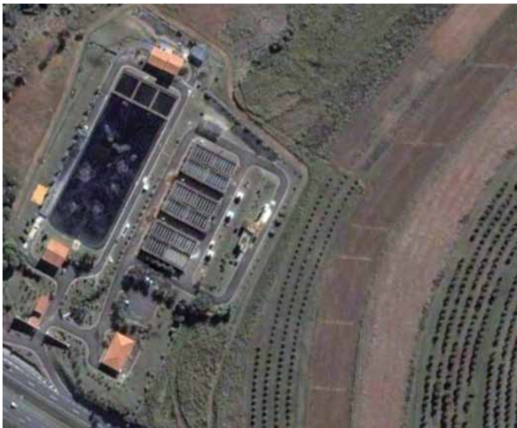
Estação de tratamento de esgoto em Piracicaba. Quanto mais perto da lavoura, melhor o aproveitamento
