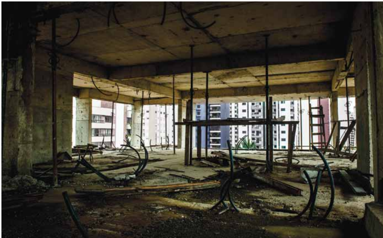
Esqueleto de un edificio en Vila Leopoldina, en la zona oeste de São Paulo, en primer plano. Al fondo, edificios nuevos que surgieron durante el boom inmobiliario de los primeros años de este siglo
