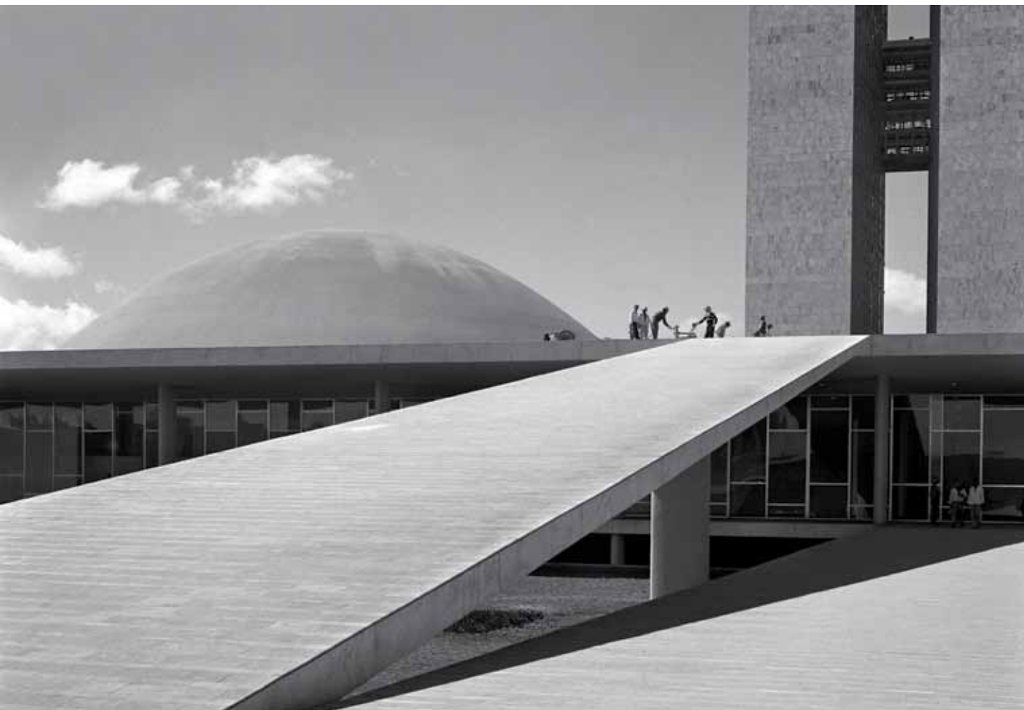
Últimos retoques en la rampa del Congreso Nacional para su inauguración (1960)
