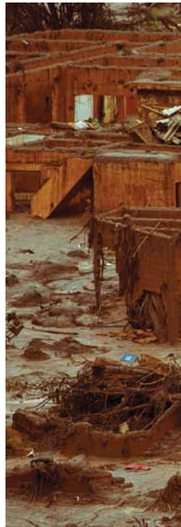
Vila de Mariana devastada pela lama da barragem de Fundão: efeito a mais de 800 km de distância na terra, no rio e no mar
