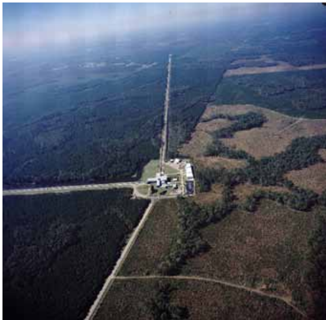
Os dois observatórios do Ligo têm braços em formato de L com 4 km de extensão, um em Hanford, no estado de Washington, e outro em Livingston, na Louisiana (à esq.)
