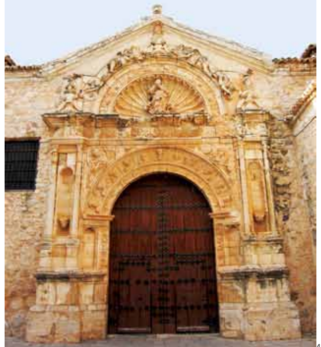
Material criado em São Carlos é testado em fachada de igreja espanhola
