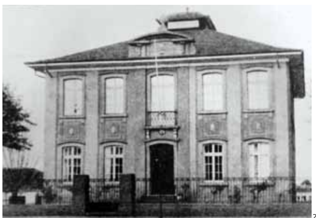
Fachada do Instituto Pasteur de São Paulo, inaugurado em agosto de 1903, na capital
