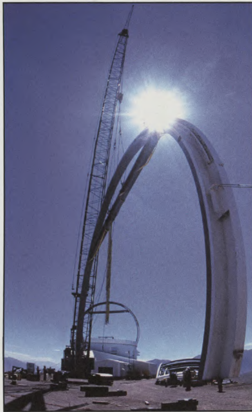
Travaux dans les Andes: anneau de 20 mètres...
