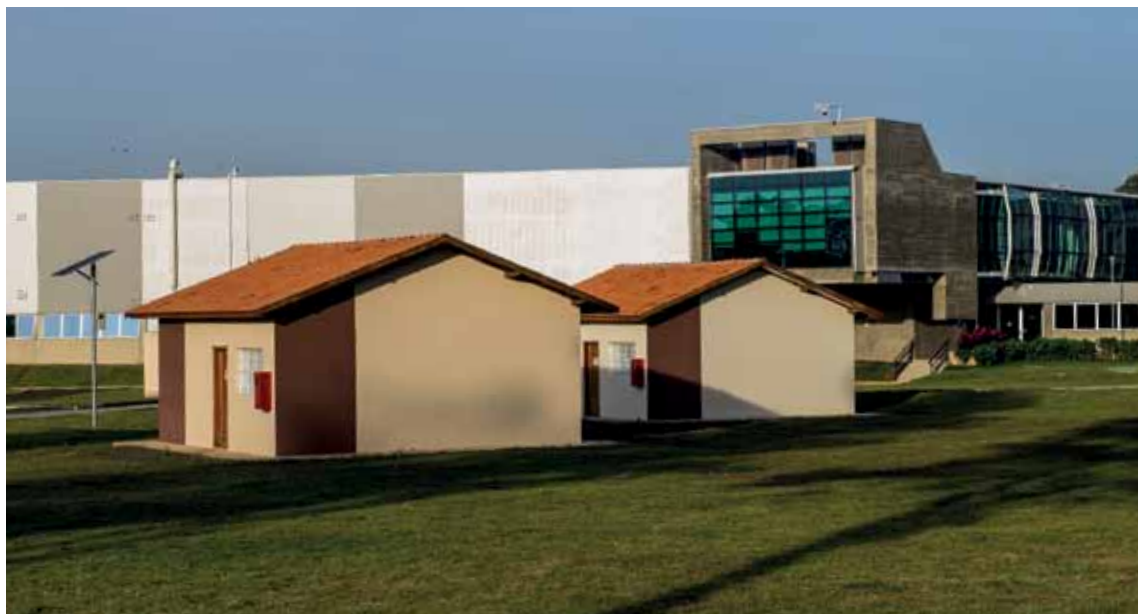
Casas construídas na área externa do centro de P&D são usadas para testar novos forros projetados para elevar o conforto térmico de seus usuários
