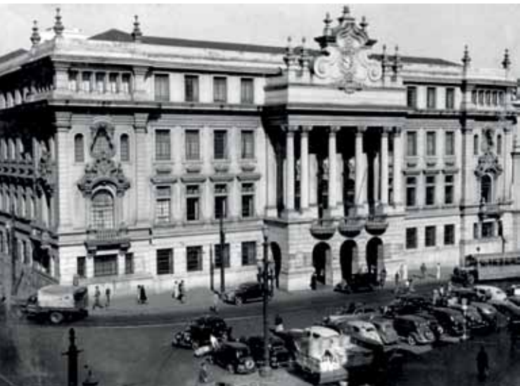
Prédio construído para abrigar o curso paulista, no Largo São Francisco, região central da cidade
