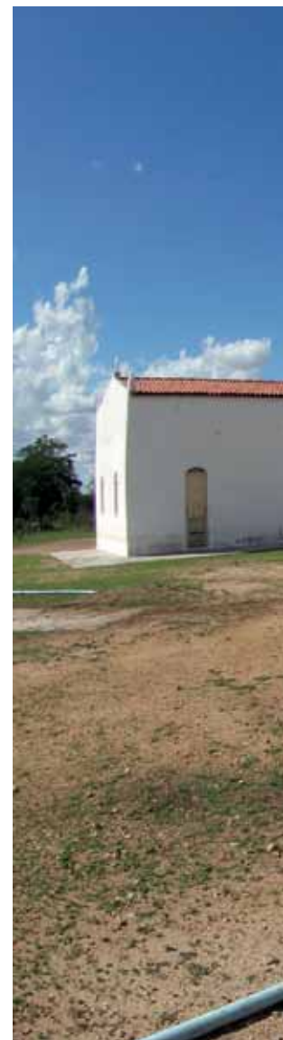
Instalações do sistema de purificação de água salobra na comunidade de Pedra Bonita, em Pé de Serra, na Bahia
