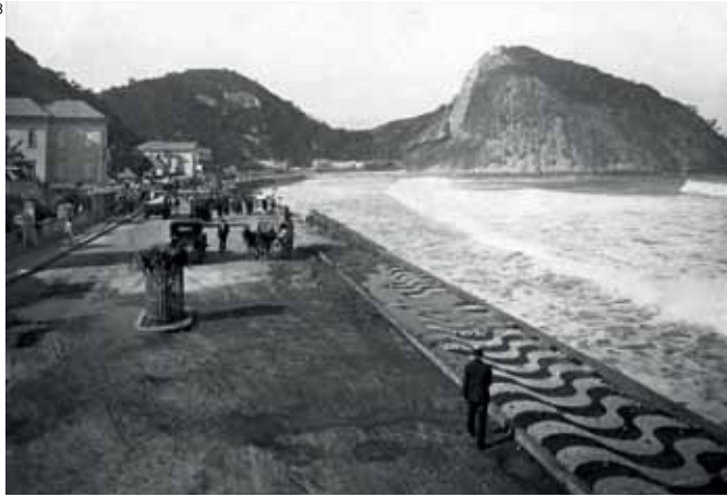
Em 1921, a praia de Copacabana era estreita e o mar invadia a avenida. A ampliação da praia, com areia de áreas próximas, resolveu o problema
