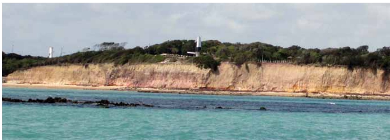
A encosta que sustenta o farol da Ponta do Seixas, em João Pessoa, sofre erosão contínua
