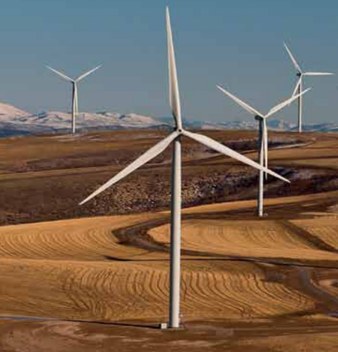
Alinhamento irregular de aerogeradores aumenta a produção de eletricidade
