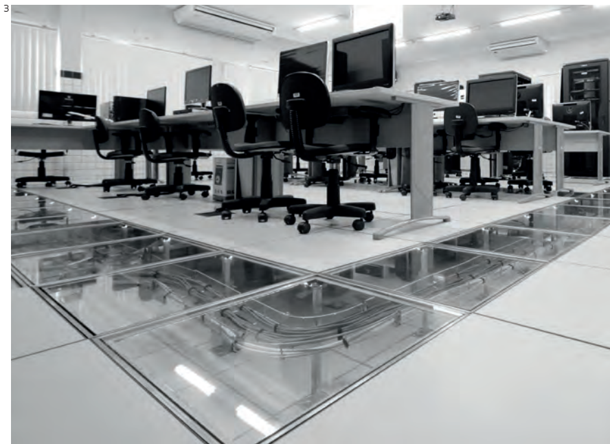
Laboratório de Redes de Computadores do Instituto Federal do Rio Grande do Norte, campus de São Gonçalo do Amarante
