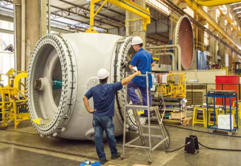
Montaje de aerogeneradores: WEG es la única empresa que los fabrica en Brasil
