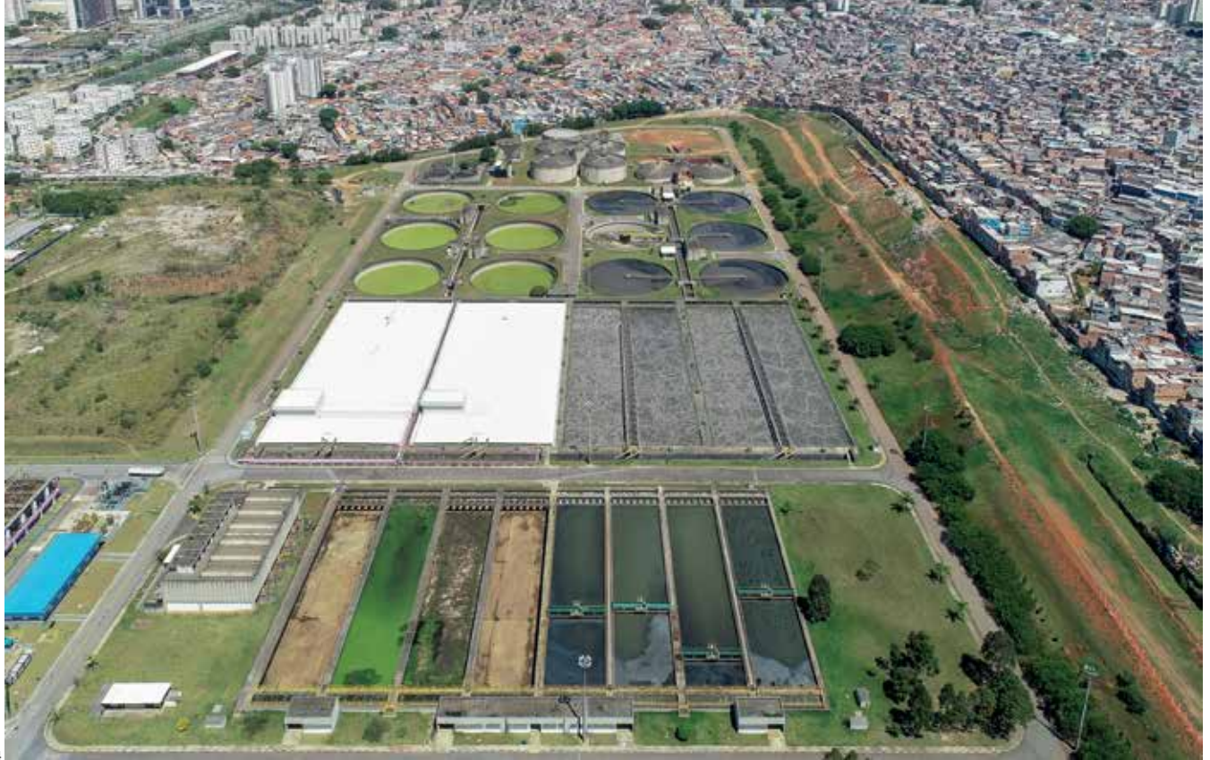
Estação de tratamento de esgoto no ABC paulista, uma das cinco em que a Cetesb acompanha a carga viral do Sars-CoV-2 na Grande São Paulo
