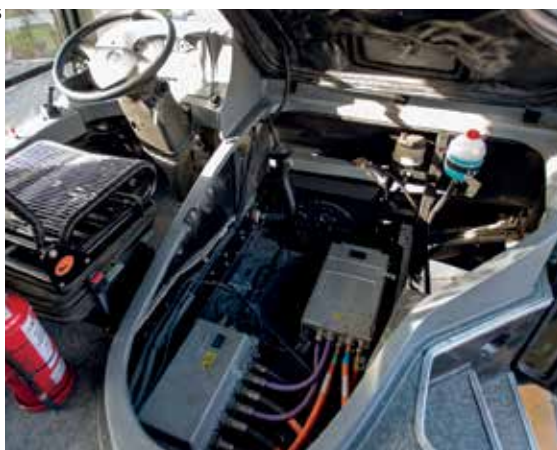
Na conversão do ônibus, o motor a combustão e o tanque de combustível originais deram lugar a um novo propulsor elétrico e às baterias de lítio
