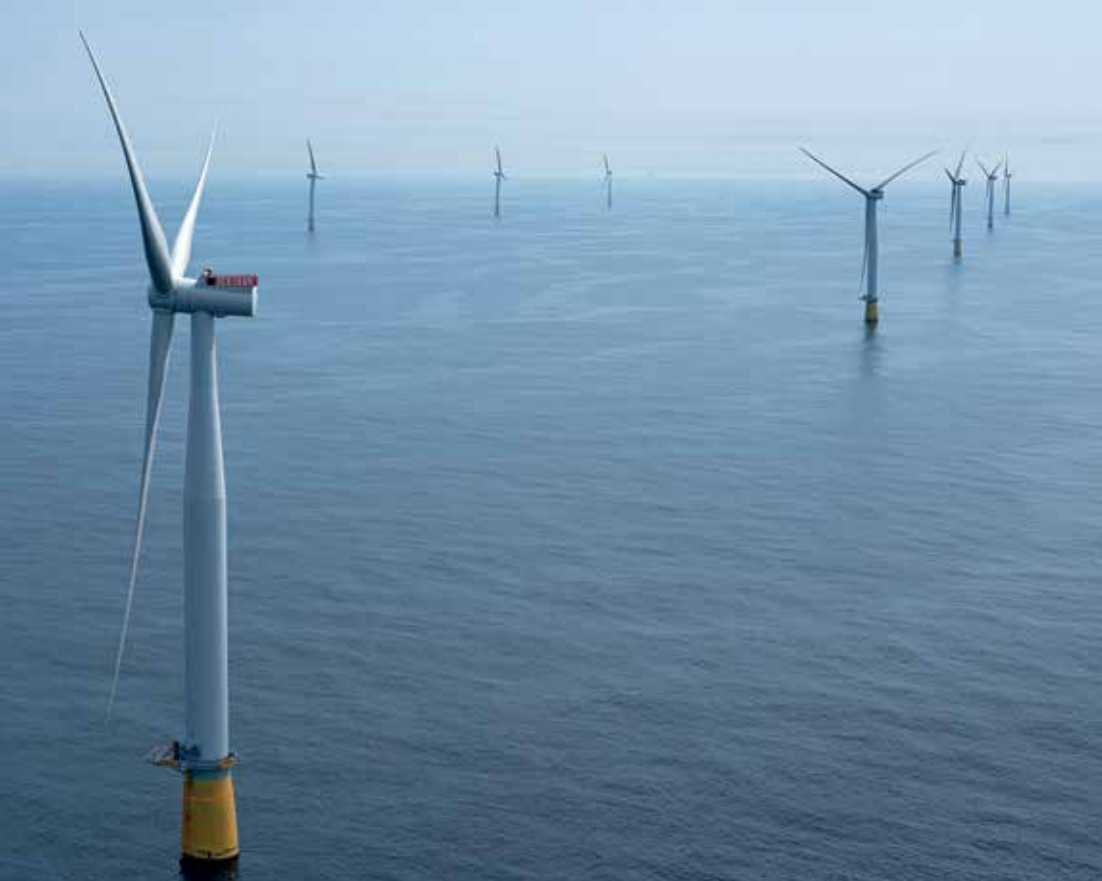
Parque eólico flutuante Hywind, na costa da Escócia: primeiro projeto comercial instalado em alto-mar
