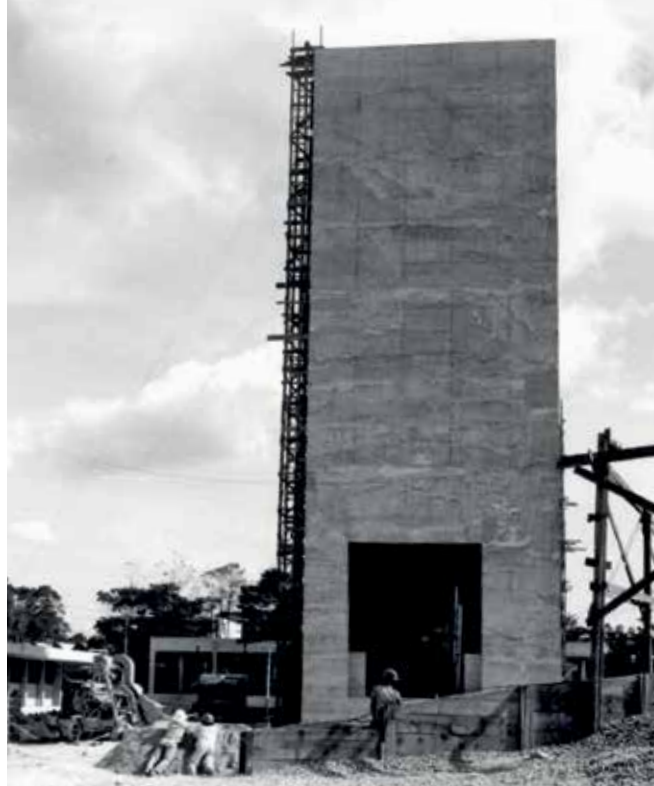
Em construção, a torre de concreto, com uma altura de oito andares, e o espaço para o tanque do acelerador, com três andares
