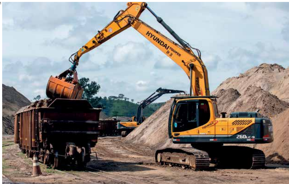
Carregamento de areia recuperada de rejeitos minerais no centro de distribuição da Agera (ao lado); fábrica de blocos da Vale que usa como matéria-prima a areia gerada no processo de extração
