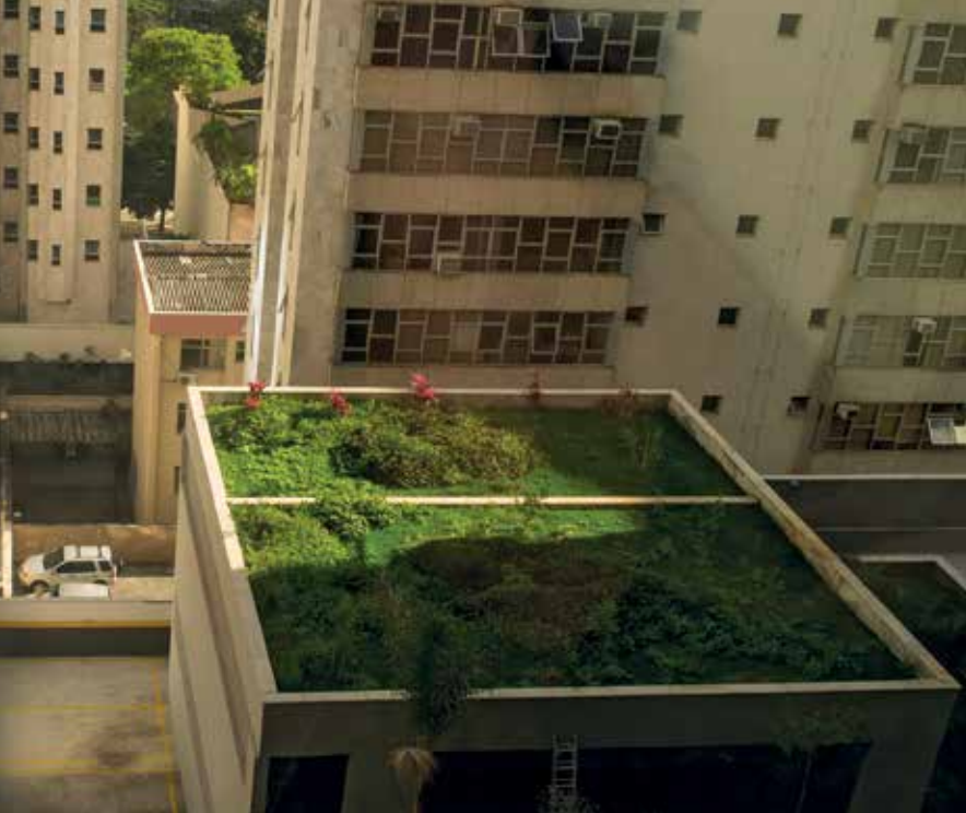
Edifício com teto verde em Belo Horizonte: alternativa para reduzir a temperatura interna
