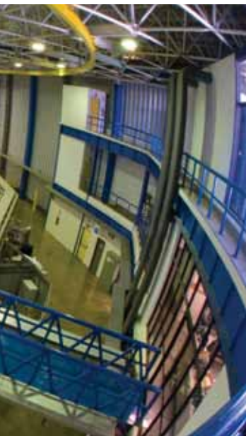
1 Laboratório Nacional de Luz Síncrotron, em Campinas: construção de uma nova fonte
